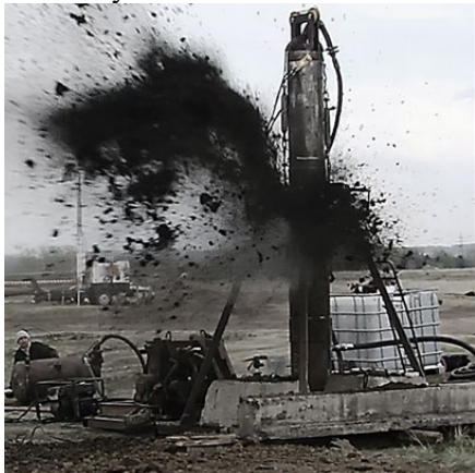
Рисунок 10 — Процесс погружения трубы и выхода породы
