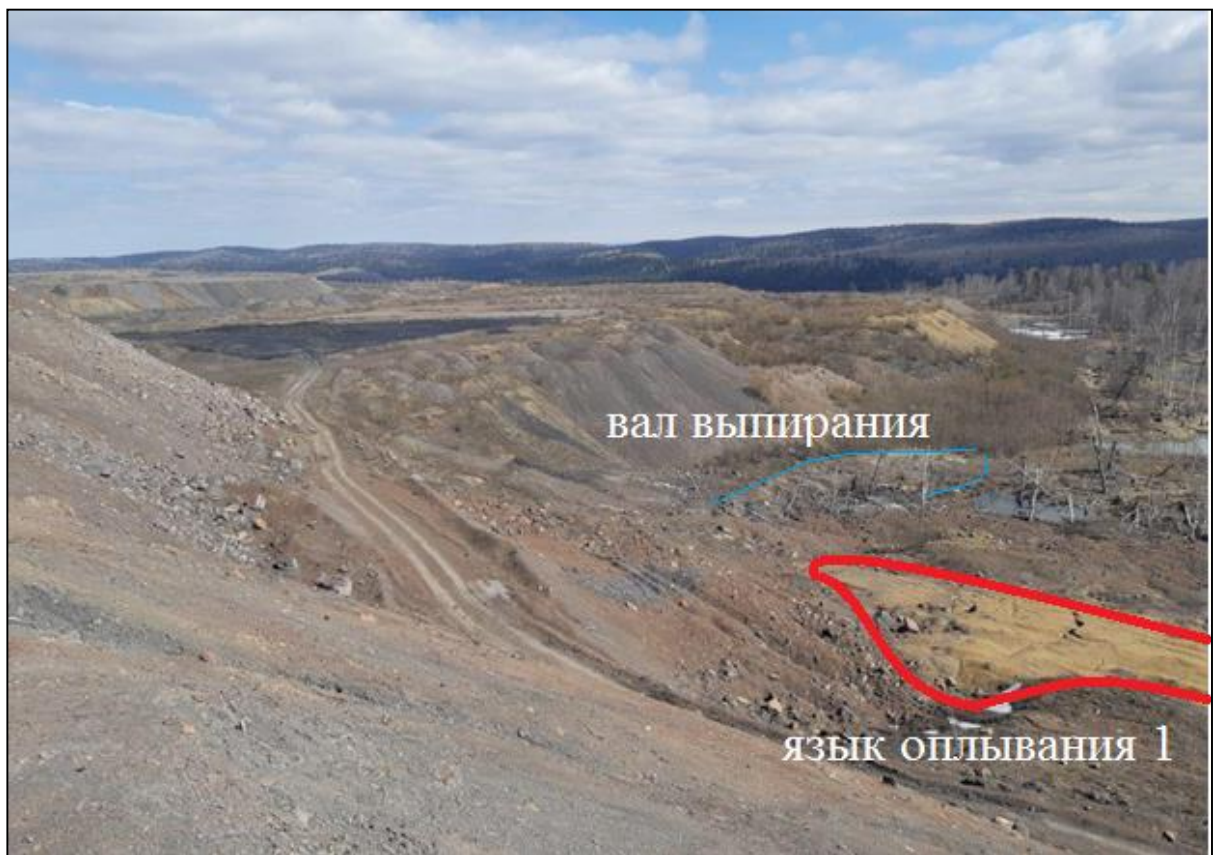
Рисунок 1.10 – Фотографии натурного обследования деформации на отвале Южный с указанием вала выпирания и языка оплывания
