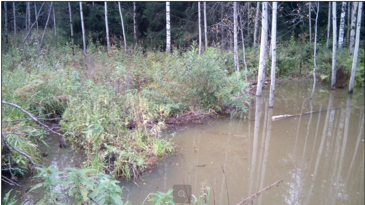
Рисунок 1.12 – Фотографии натурального обследования участка деформации на отвале «Северный» – затопленные березы, не произрастающие в таких условиях, еще не успевшие почернеть.
