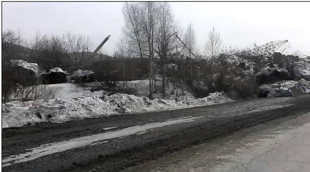
Рисунок 1.8 – Язык оползня, перекрывающий автодорогу, на отвале разреза «Заречный» в апреле 2015 года, кадр видеосъемки
