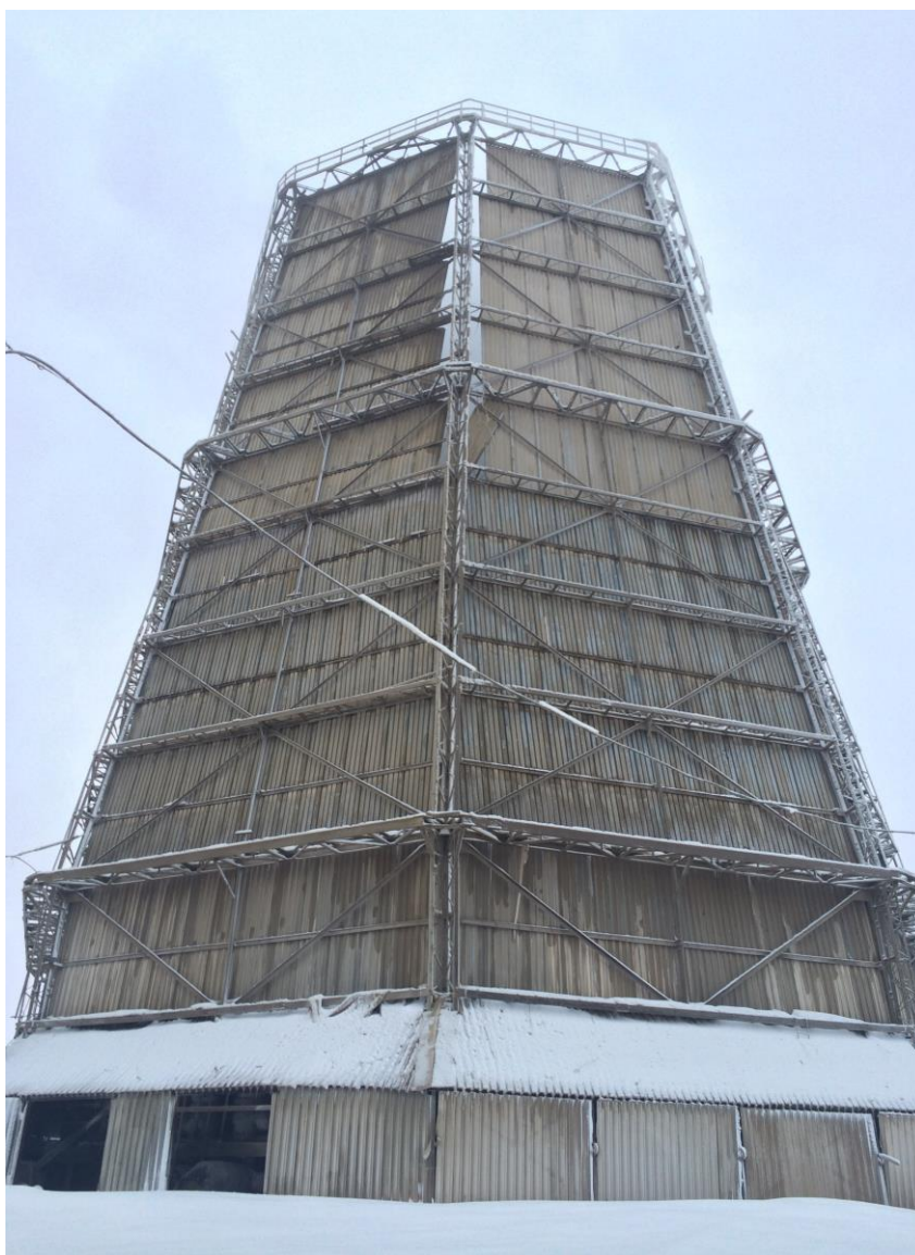
Рисунок 4 – Башенная градирня ООО «БазэлЦемент-Пикалево»
