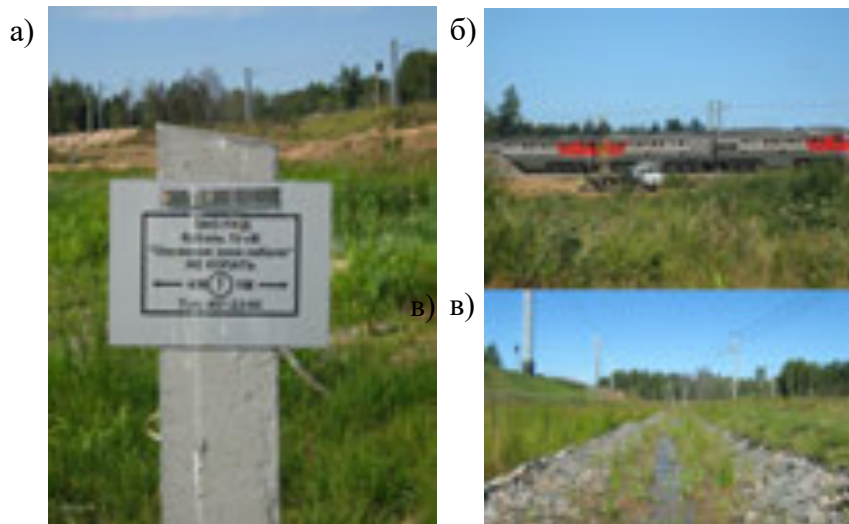
Рисунок 4.3 – Источники техногенных помех в полосе отвода железной дороги: (а) кабель высокого напряжения; (б) железнодорожные составы; (в) металлические конструкции
