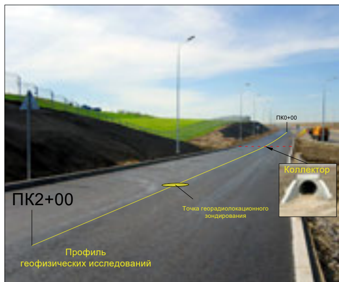
Рисунок 4.32 – Участок новой автодороги
