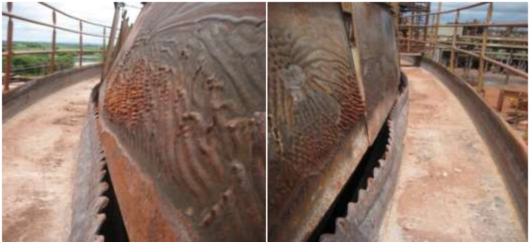
Рисунок 2.4 – Кольцевой сливной желоб
