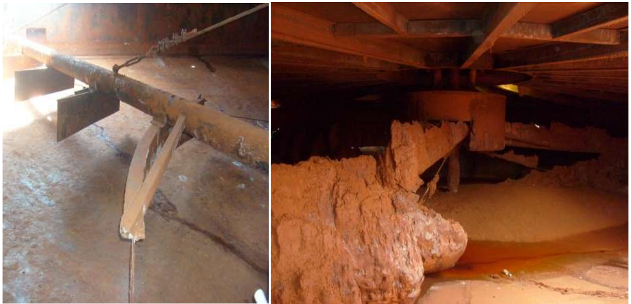
Рисунок 2.7 – Гребковая рама сгустителя – две радиально расположенных граблины с прикрепленными к ним гребками
