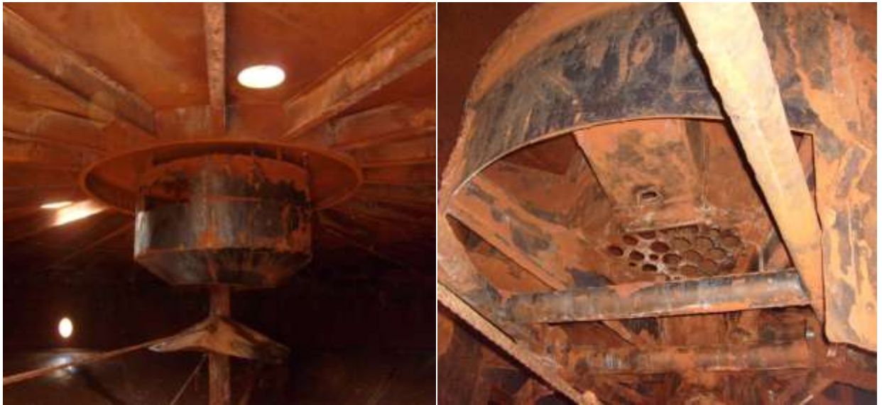
Рисунок 2.6 – Питающий колодец с поперечной решеткой внутри для улавливания случайных крупных предметов и для гашения скорости потока поступающей пульпы
