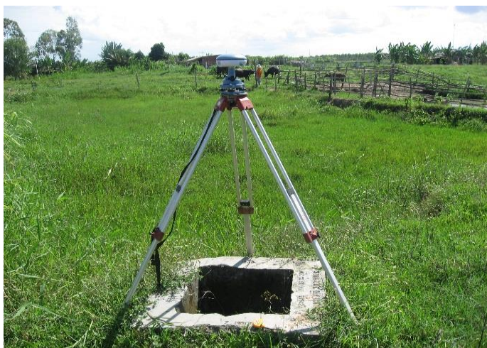
Рисунок 1.20 – Вид пункта ГГС (наземный)
